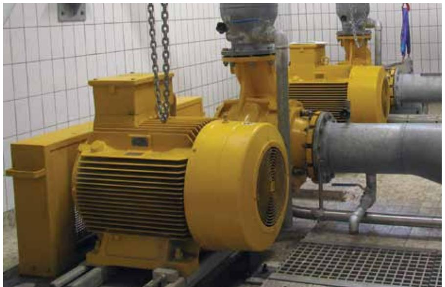
Gerade bei Abwasserpumpen kommt es häufiger zur Verstopfung. Der Rückspülmodus des VLT® AQUA Drive sorgt für einen wirkungsvollen Schutz.
